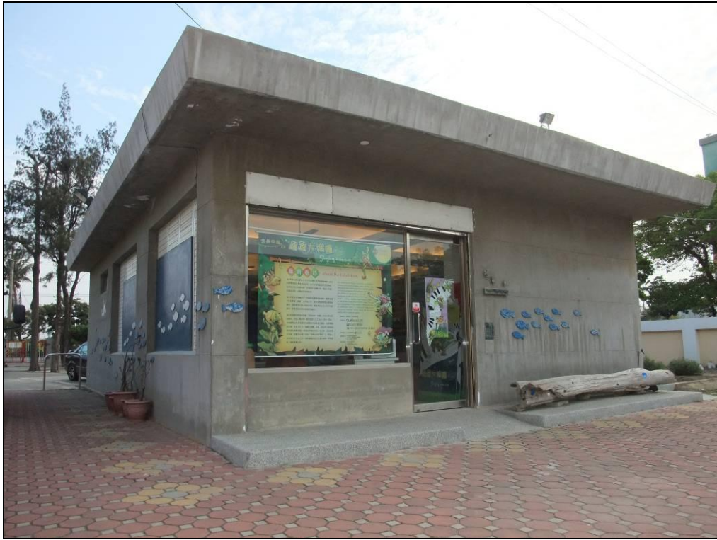
中心正面及左側，有獨立出入側門。
