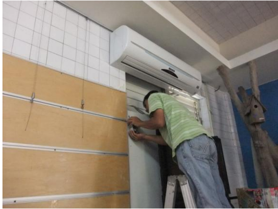
社區中心新增設備安裝情形
