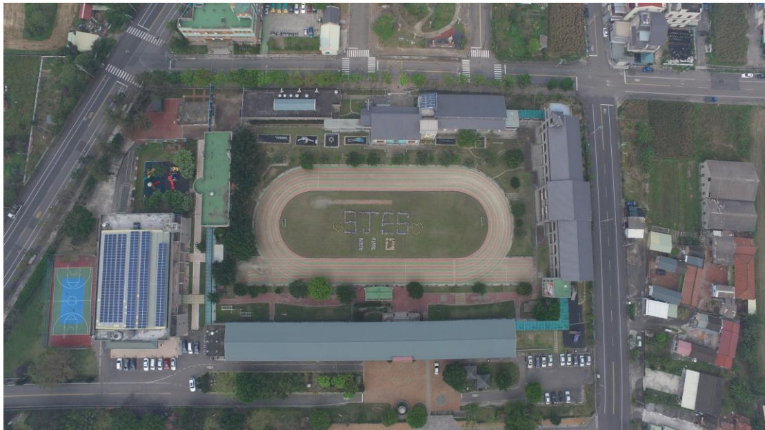
臺南市學甲區學甲國小透水區域空照圖
