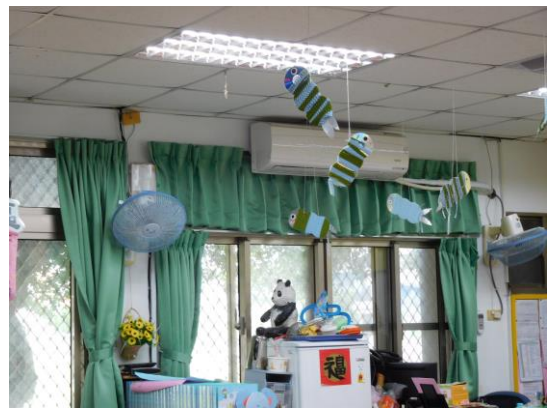
班班裝設節能燈管
