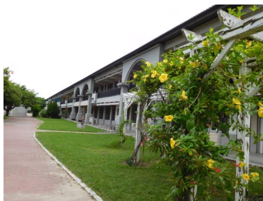
大智樓斜屋頂
